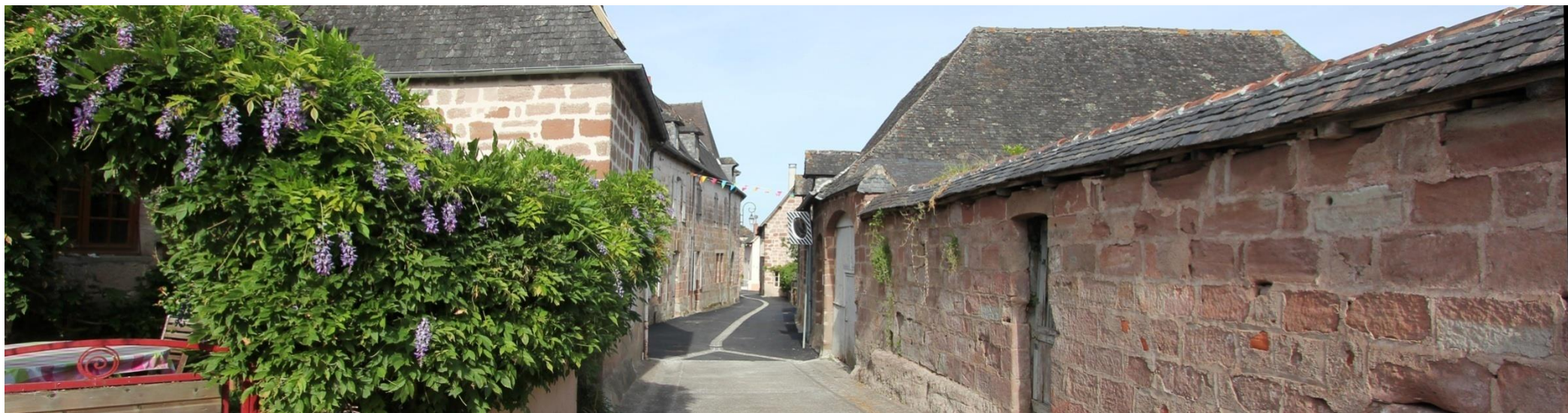
Vars-sur-Roseix affiche une pierre brune et une belle unité de tons et style architectural. Les quelques petites ruelles (réaménagées) qui traversent ce bourg lui apportent son cachet.
