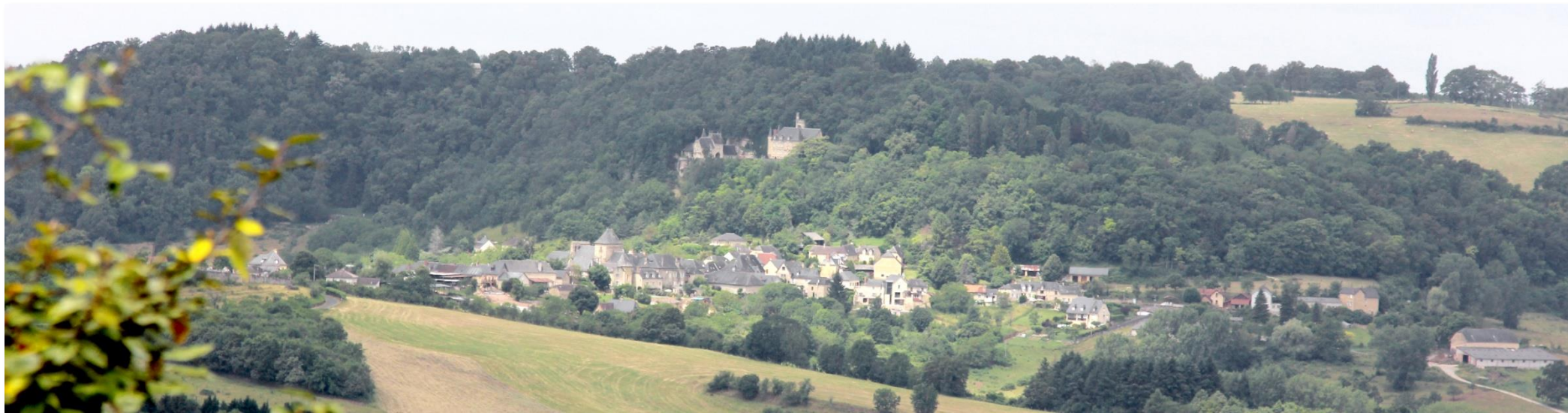
3 points de vue lointains donnent sur le bourg de Perpezac, permettant d'apprécier son organisation urbaine. Vue depuis la table d'observation Nord d'Yssandon.
