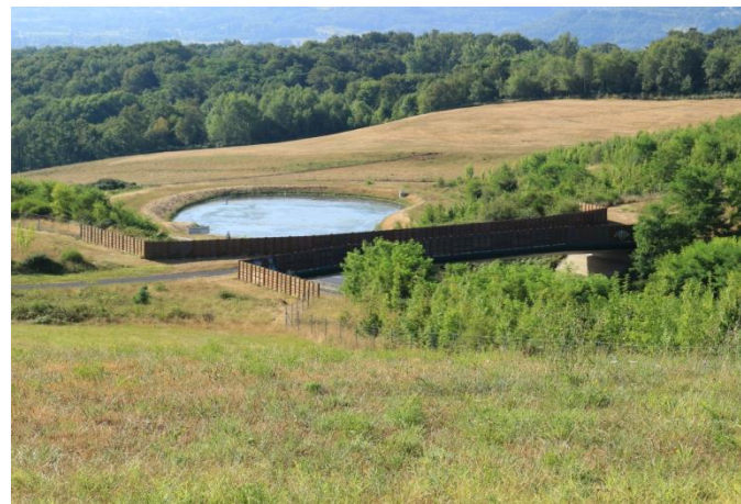
Passage à faune sur la route entre la route Les Marnas et la Route de la Bombetterie
