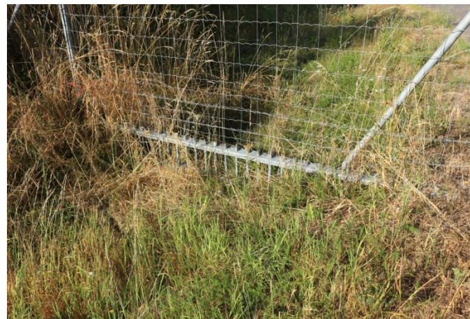
Clôture perméable au niveau du passage d'un fossé
