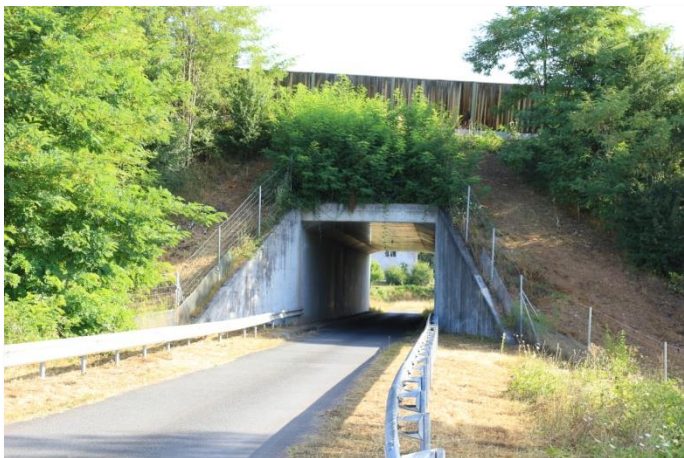
Franchissement d'autoroute à la jonction des routes de La Combe et d'Azinieras
